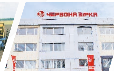
У 2003 році завод перейменовано на «Червона зірка».
